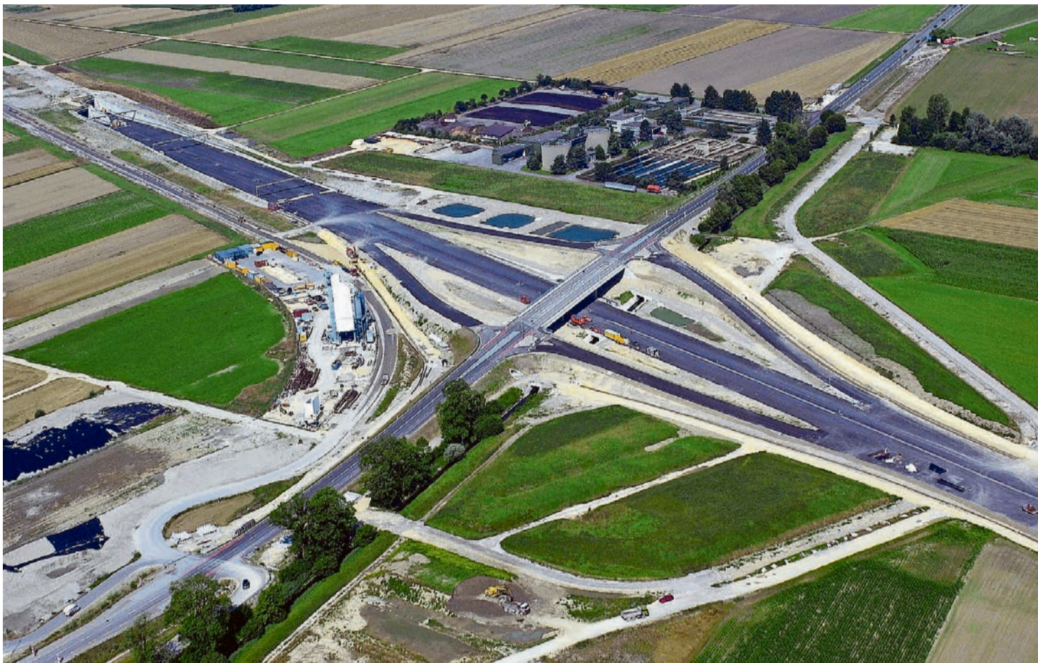
Autobahnanschluss Grenchen 2001 vor der Fertigstellung. Oben links sieht man das Portal des Witi-Tunnels.
