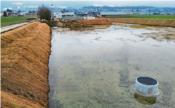
Ein Biotop: Neues Retentionsbecken der Kläranlage Selzach.
